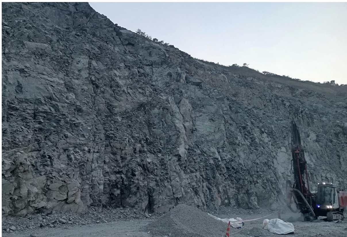
Figure 71 : L'état du mur de Bonikro
