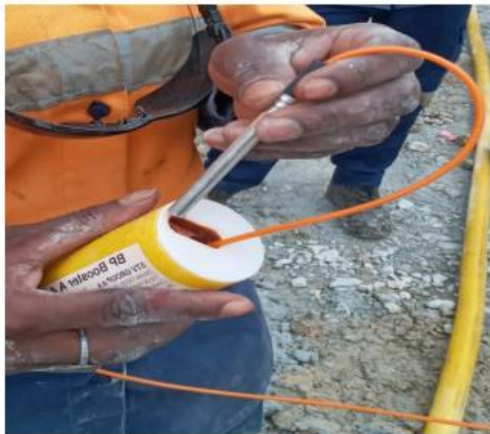
Figure 14 : Amorçage à l'aide de booster
