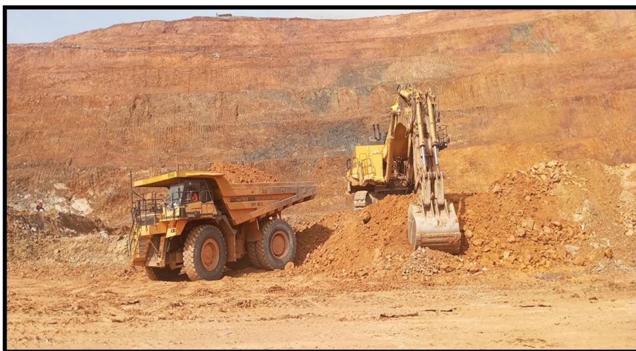
Figure 7 : Chargement d'un Tombereau rigide en Bottom Loading par une pelle hydraulique KOMATSU PC2000
