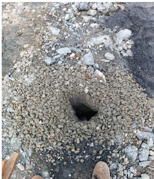
Figure 31 : Trous présentant un bourrage apparent
