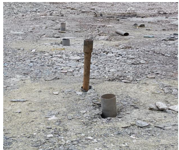
Figure 30 : Tige coincée lors de la foration
